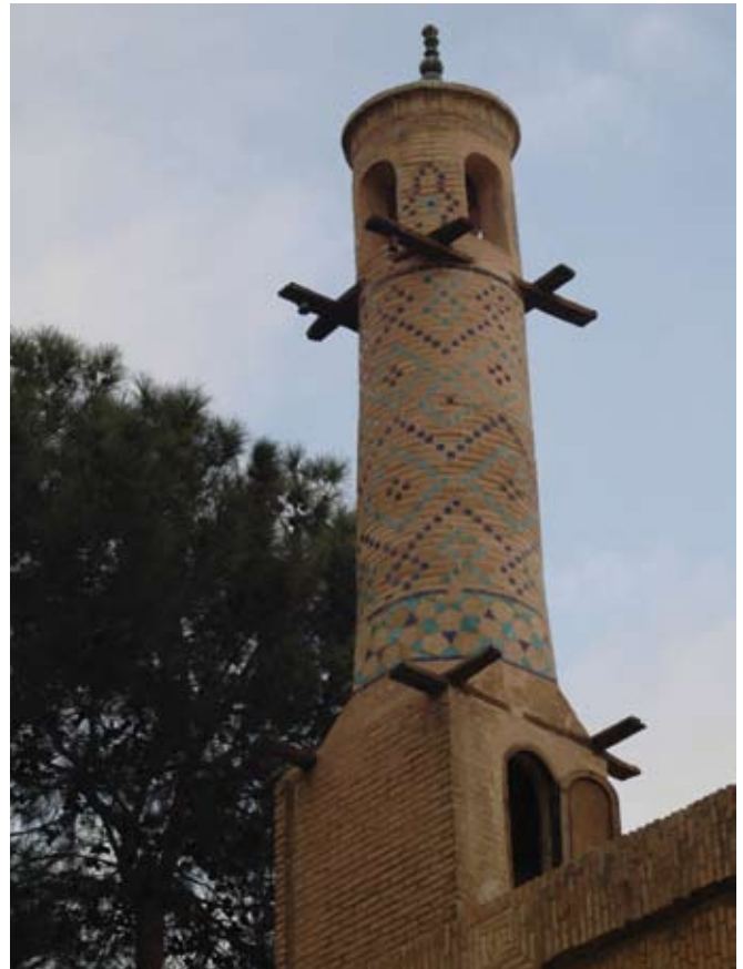
Zibajoči se minaret, Esfahan
